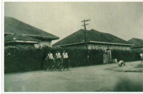
อาคารเดิมของโรงพยาบาลก่อนการปรับปรุง
